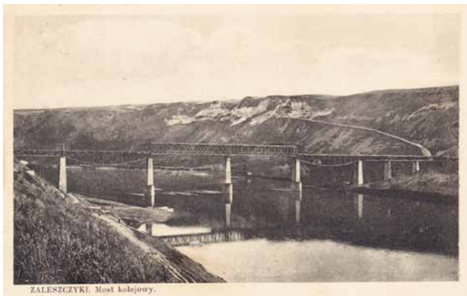
ZALESZCZYKI. Most kolejowy.
