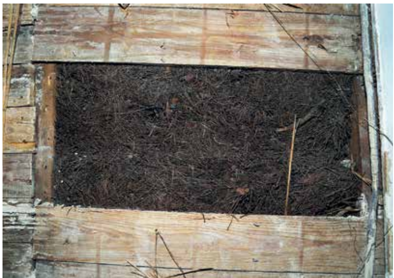
6 | Wnętrze ściany willi wypełnione igliwem
